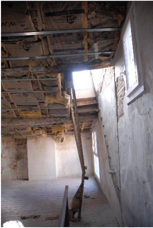
*Ai 04-07 : effondrement du toit et du dernier plancher*
