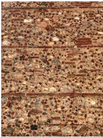
Le XIXe s. a apporté sa contribution dans une forme d'opposition au discours précédent : de nombreuses maçonneries de cette période se présentent sous forme de banches rythmées par des chaînages en cayrous et composées de moellons rejointoyés au mortier de chaux avec incrustations de cabochons de terre cuite, parfois de mâchefer, parfois les deux.
