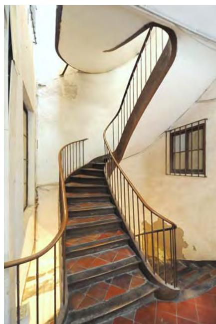
Exemples de développement maximal afin d'assurer le franchissement des étages dans un minimum de place.
