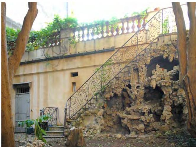
*La Réal AE 14-206 – Balustres pierre et éléments de ferronnerie forgée.*
