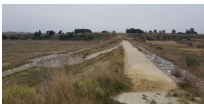
Barrage aval de la Courragade et son déversoir
