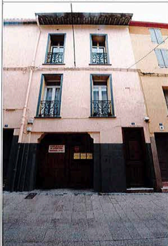
Façade rue de la Lanterne
