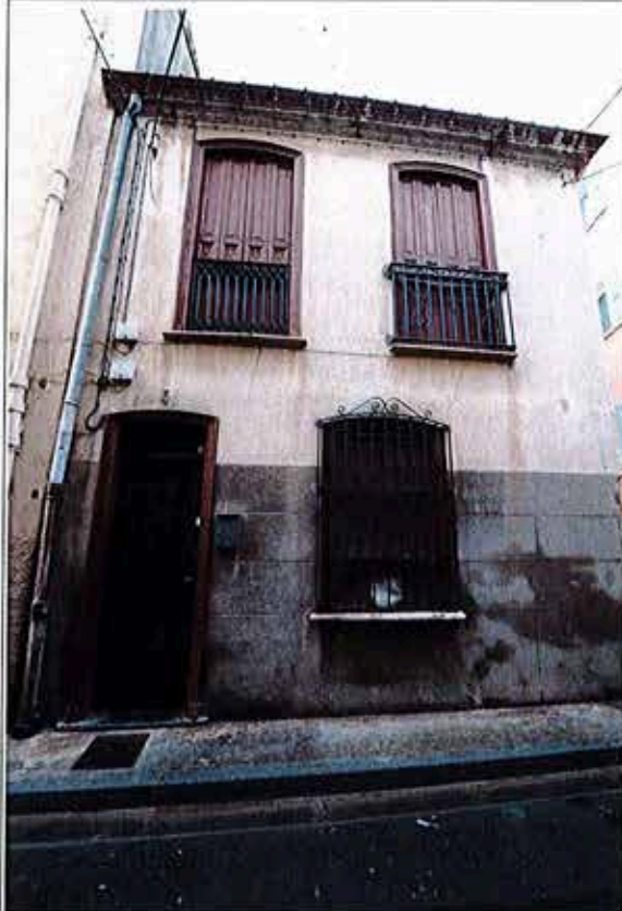
Façade rue des Commères
