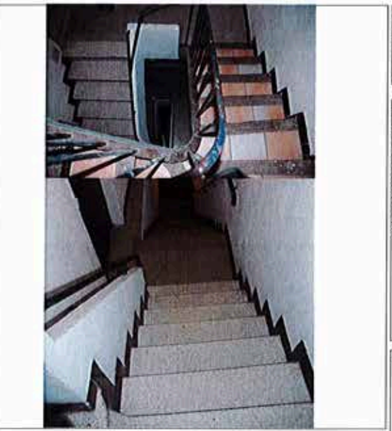
Escaliers: droit étage 1 & 2 et balancé étage 3
