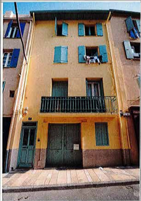
Façade rue Dugommier
