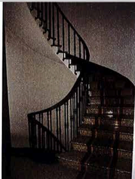
Escalier tournant suspendu avec décor terrazzo continu
