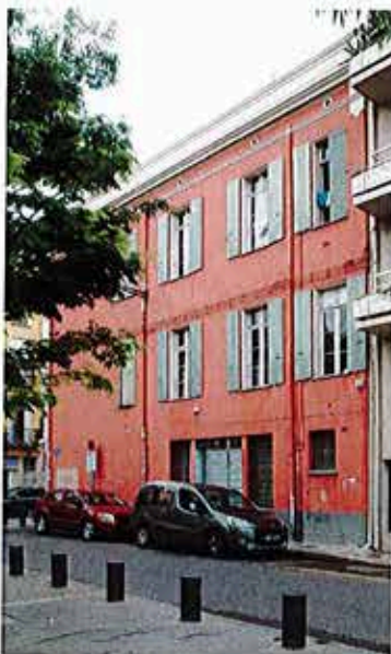
Rue du Bastion St-François
