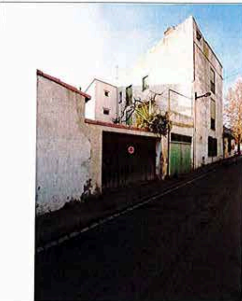
Façade rue François Villon
