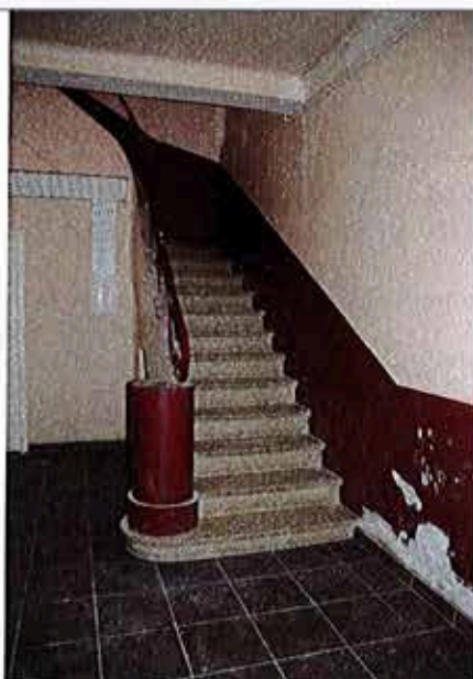
Entrée de l'immeuble
