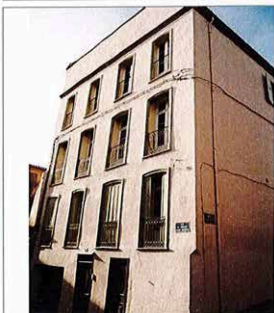
Façade rue de l'Eglise Saint-Jacques
