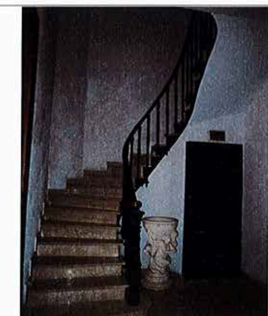
Escalier tournant suspendu & galerie formant palier
