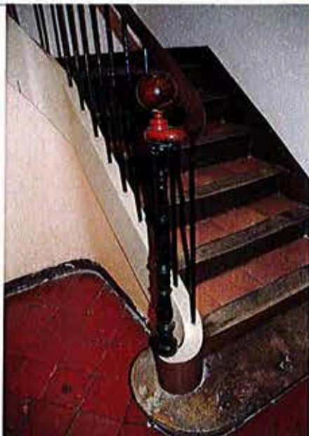
Départ de l'escalier tournant suspendu à cage vide
