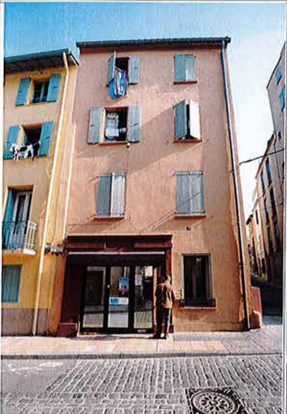
Façade rue Dugommier
