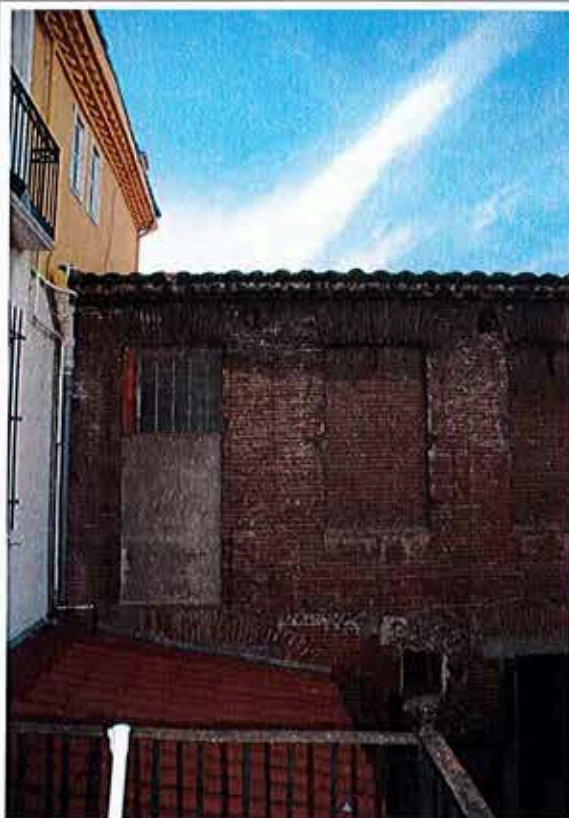
Façade sur cour côté sud-est
