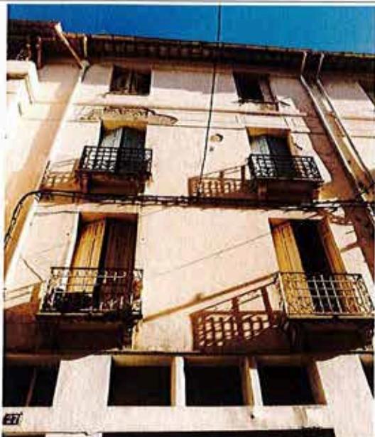
Détail des menuiseries & garde-corps
