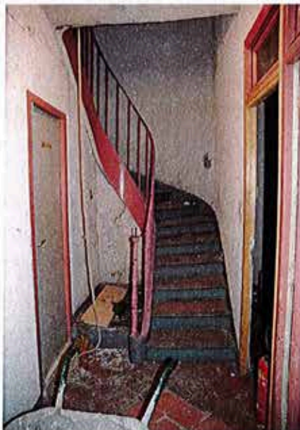
Escalier balancé étages (travaux récents)
