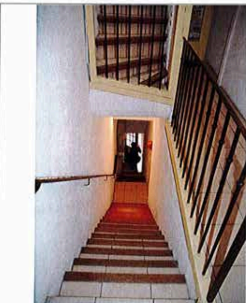
Escalier droit avec palier
