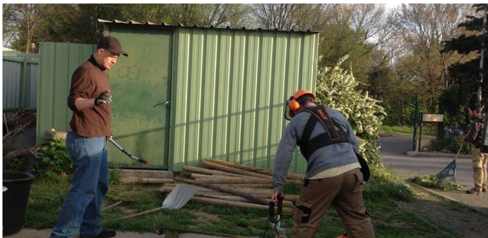
Chantier : corridors écologiques
