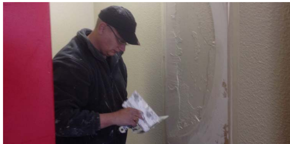
Chantier : cadre de vie et bâtiment
