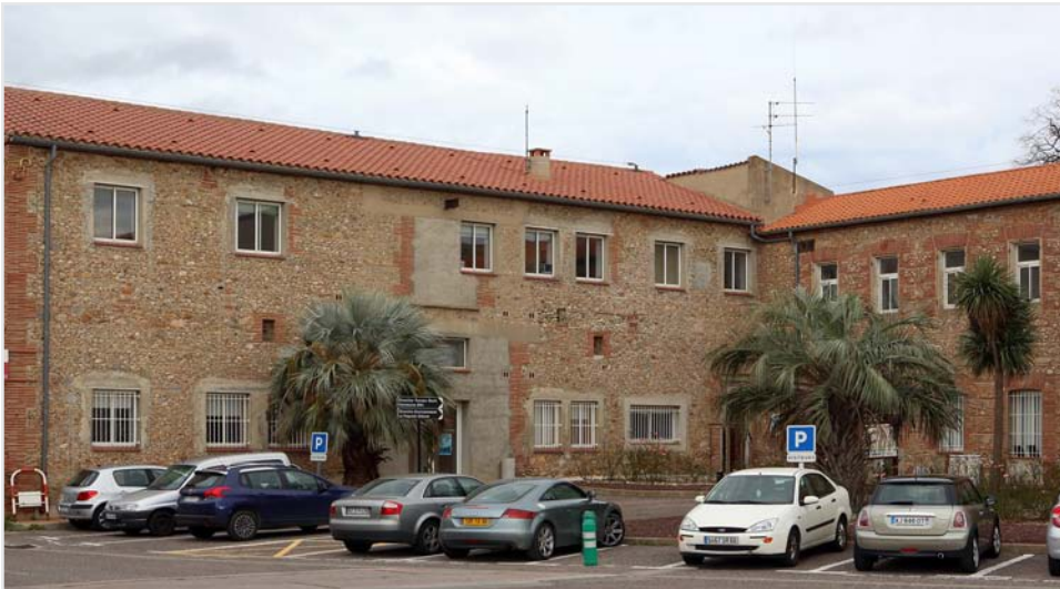
Rénovation thermique du Mas les Platanes au Centre technique Municipal
