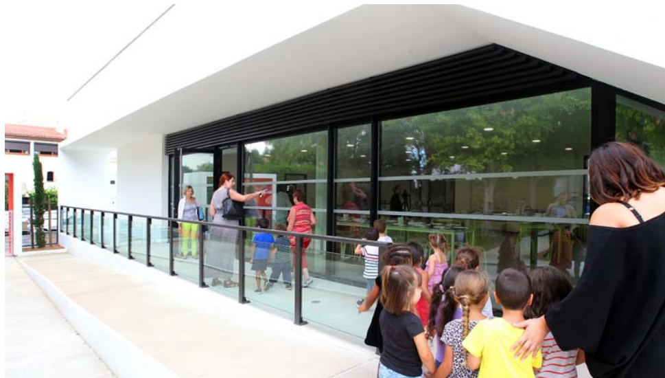
Groupe scolaire Dagneaux - construction d'un nouveau service de restauration
