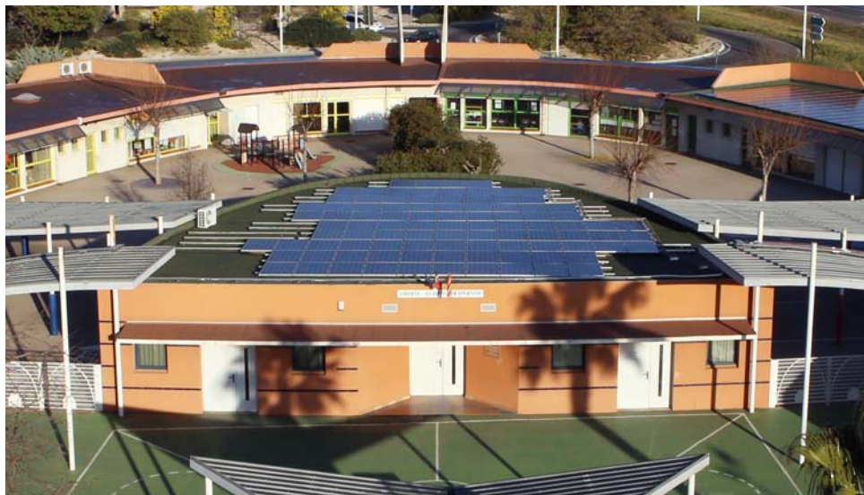
Toiture solaire : École Pont Neuf
