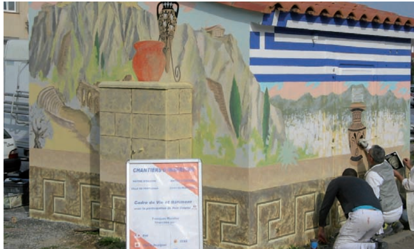
Chantier : cadre de vie/entretien
