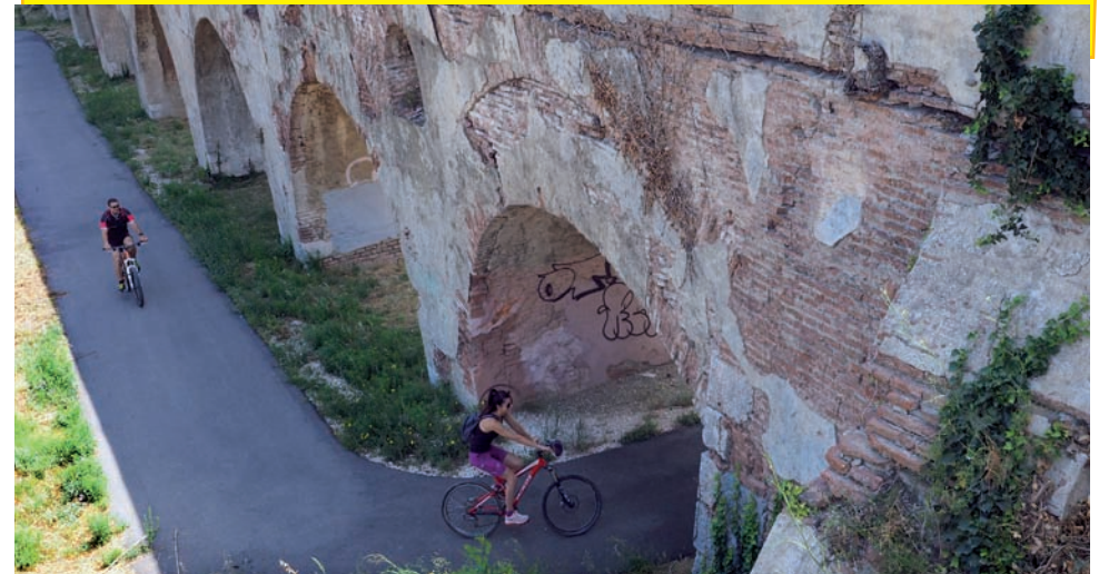
Une nouvelle piste cyclable, passe sous l'aqueduc des Arcades avant de rejoindre le chemin de la Fosselle.
