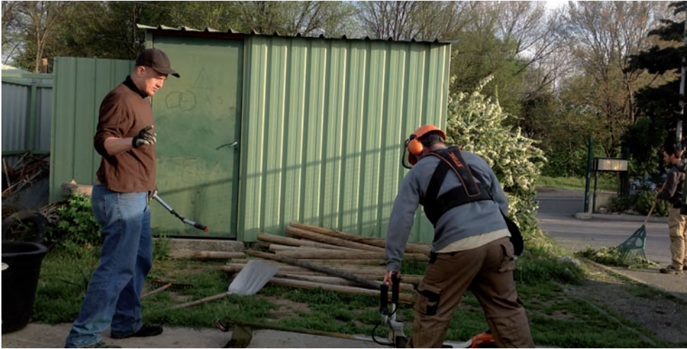
Chantier : corridors écologiques
